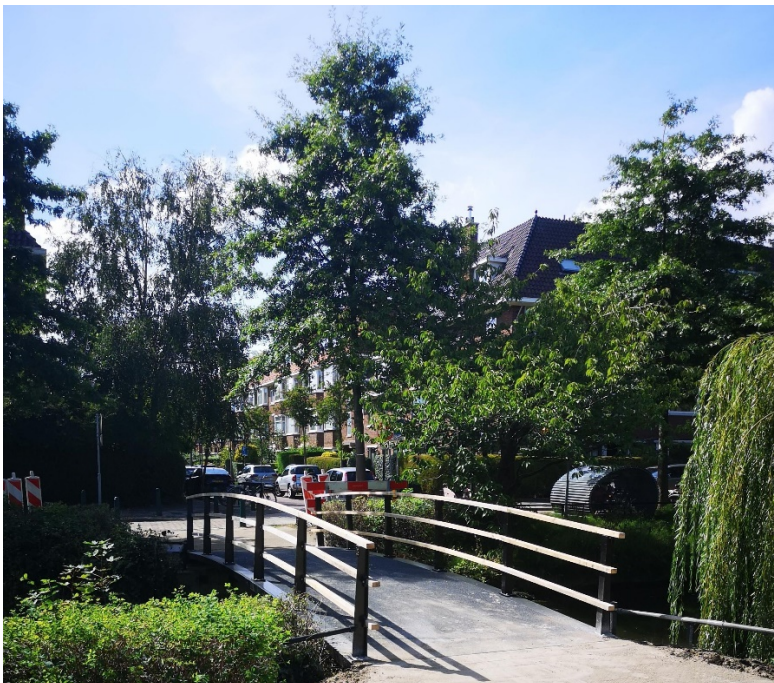
Stalen brug (Thierenskade)
