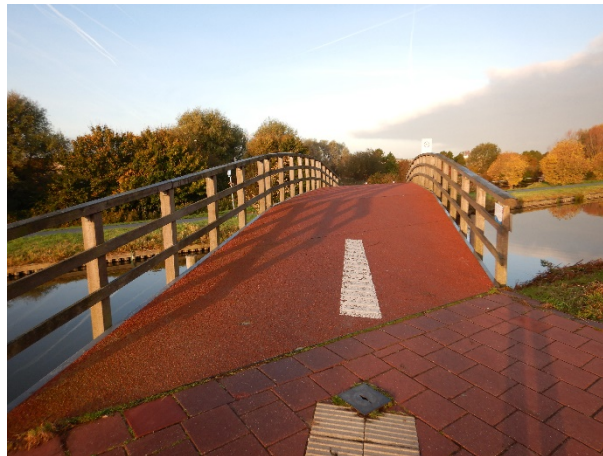
Figuur 4.10: Kunststof rijdek brug B181.
