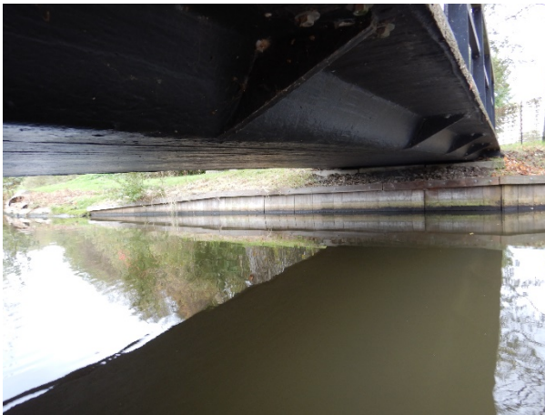
Figuur 4.9: Kunststof hoofddraagconstructie B102.
