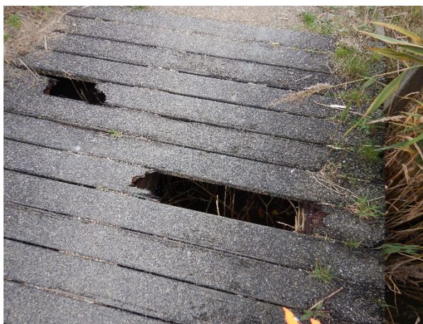
Figuur 4.7: Doorgerotte dekplanken B109 (hersteld direct na inspectie).
