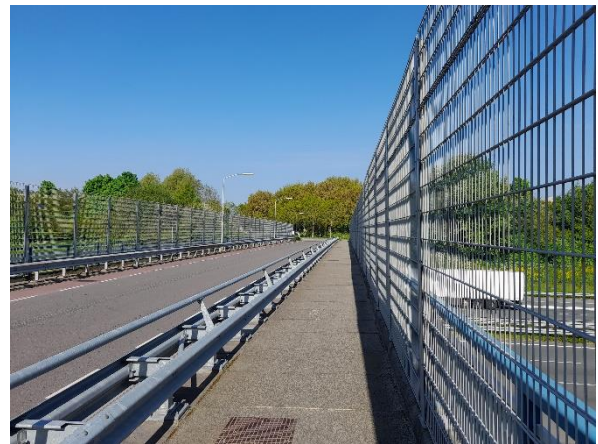
Figuur 2.6: Brug over de A4
