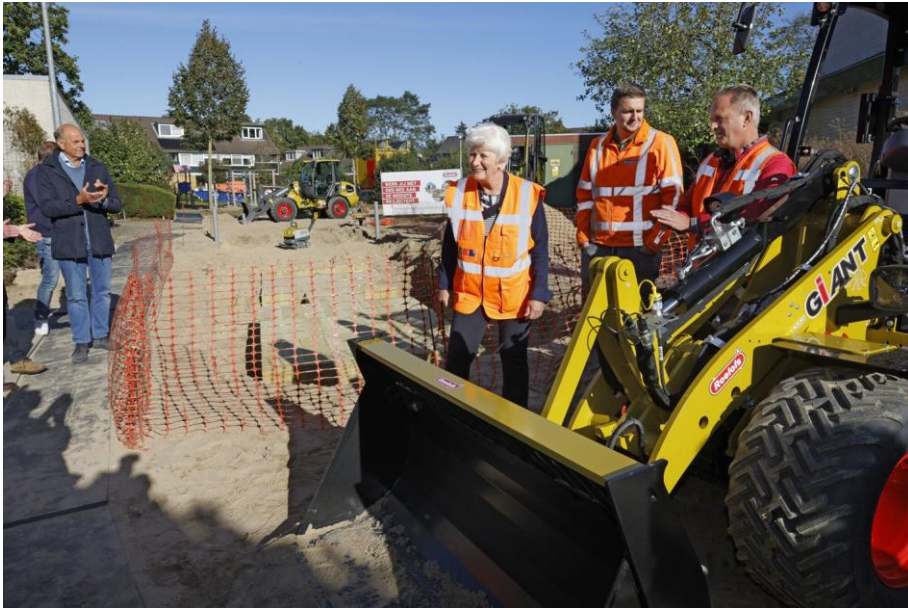
Start werkzaamheden Bijvanck
