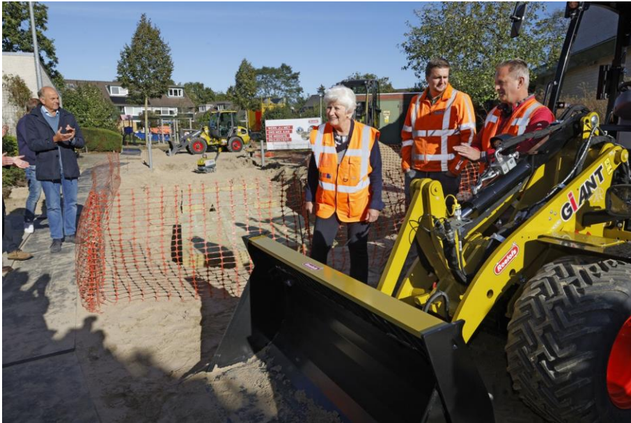
Start werkzaamheden Bijvanck
