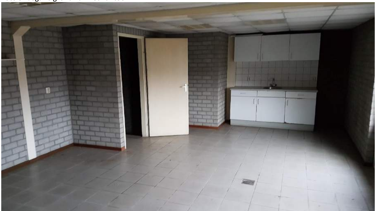
Foto 6: eerste verdieping van het kantoor.
