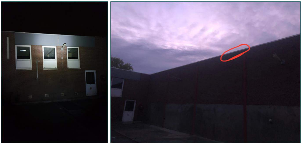
Figuur 3.2 De opening van de paarverblijfplaats gewone dwergvleermuis bevindt zich aannemelijk tussen de trespapanelen (links). De openingen van de zomerverblijfplaats gewone dwergvleermuis bevindt zich tussen de daklijst en gevel (rechts).
