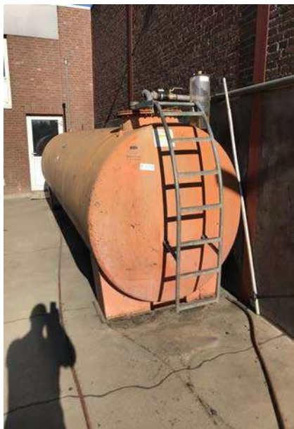
Foto 7. Bovengrondse dieseltank
