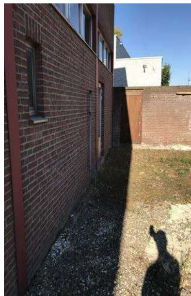
Foto 12. Vml ondergrondse tank
