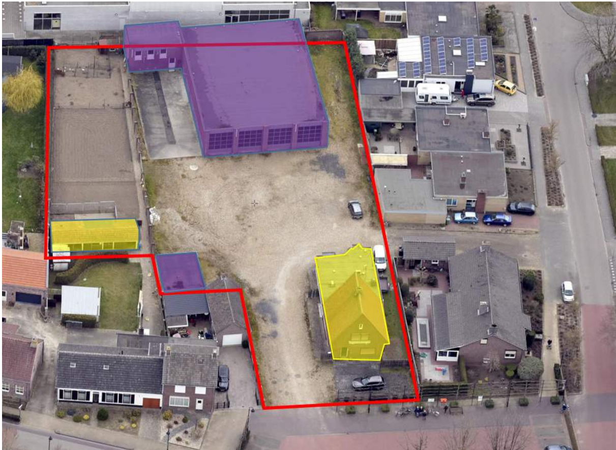
Afbeelding 8: Overzichtsfoto huidige situatie plangebied. Plangebied aangeduid met rode lijn. Bestaande bebouwing ten behoeve van wonen geel aangeduid. Bestaande bedrijfsbebouwing met paars aangeduid.
