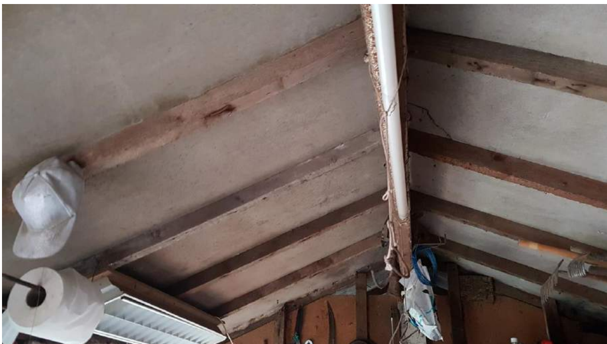
Foto 19: beplating van het dakbeschot.
