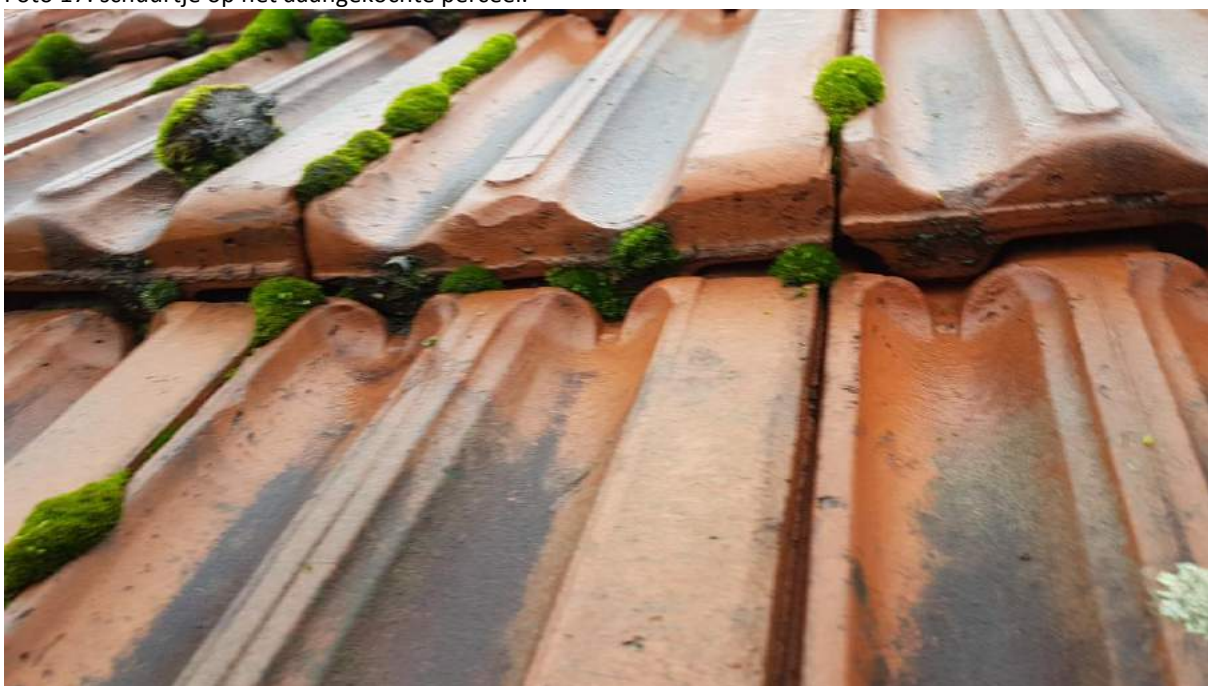
Foto 18: nauw aansluitende pannen van het schuurtje op het aangekochte terrein.
