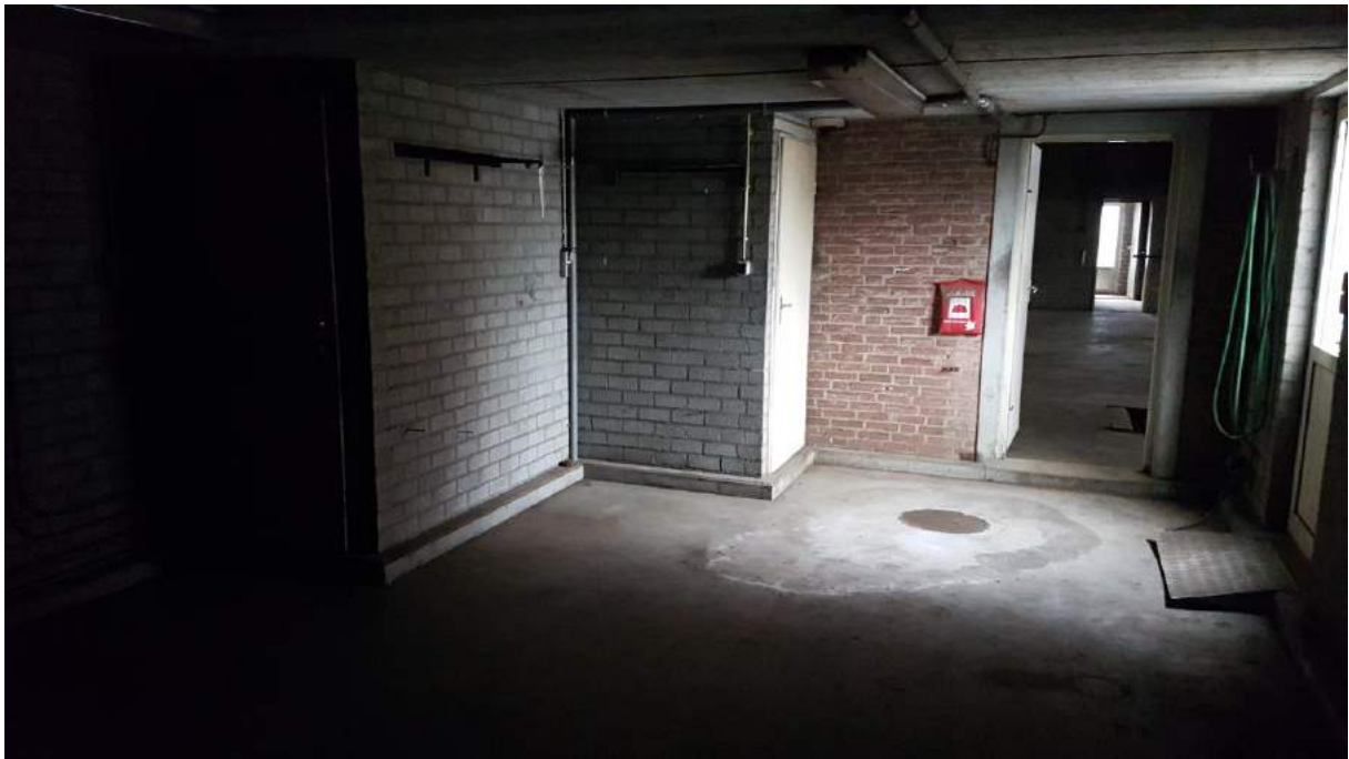
Foto 5: begane grond van het kantoor
