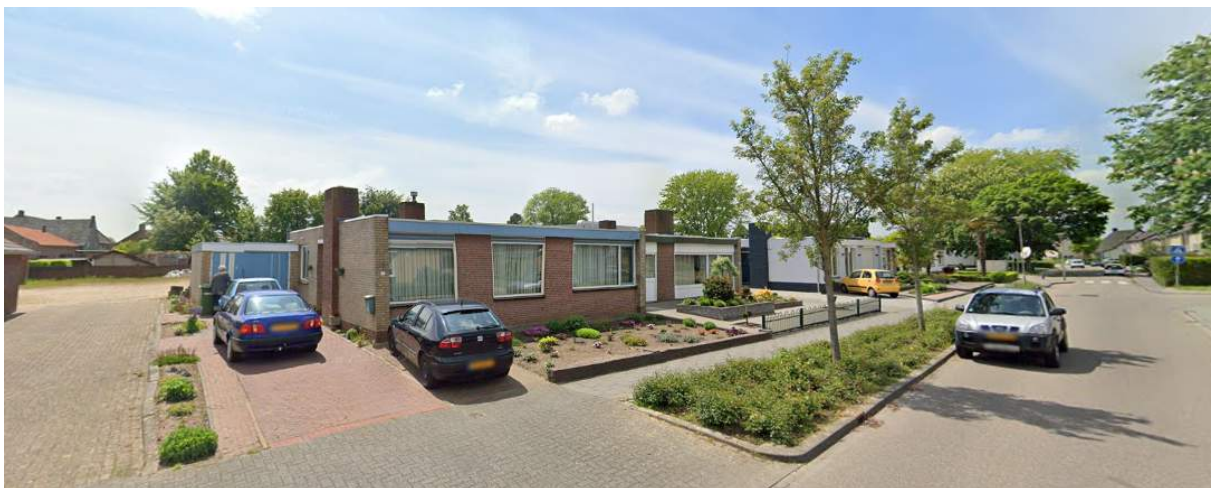
Afbeelding 5: Woningen Prinses Magrietlaan
