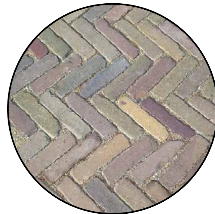
Verharding van oude (hergebruik) gebakken klinkers, 2,5 meter breed bij wandelpad
