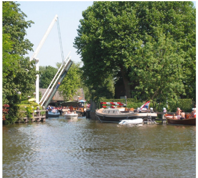
Mijndense sluis, toegangspoort tot het recreatiegebied
