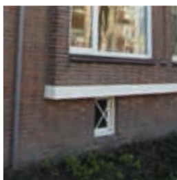
continue betonnen banden geven contrast en relief
