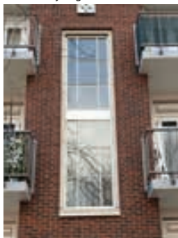
Verticaliteit trappenhuizen met verfijning en ornamenten
