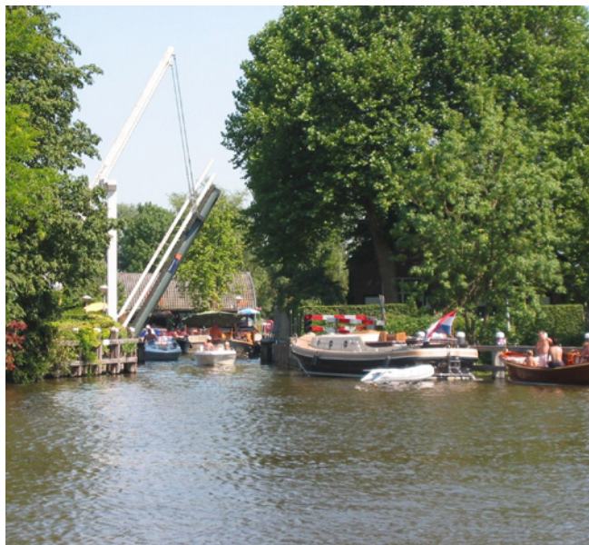
Mijndense sluis, toegangspoort tot het recreatiegebied
