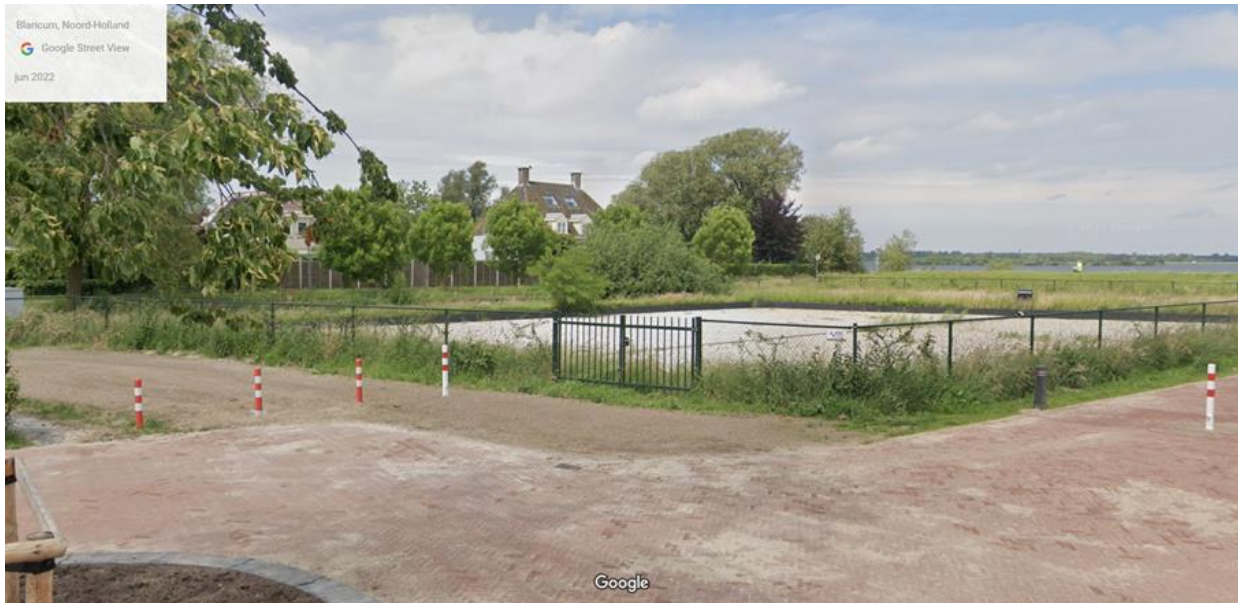
Afbeelding 1: Zandfilter zichtbaar op streetview van Google
