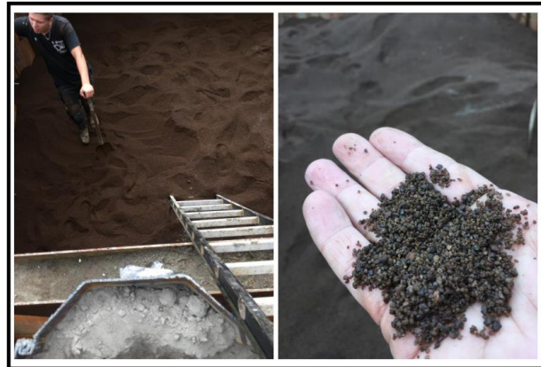
Afbeeldingen 8 en 9: bedvullingen van het filter bij Zwemlust
