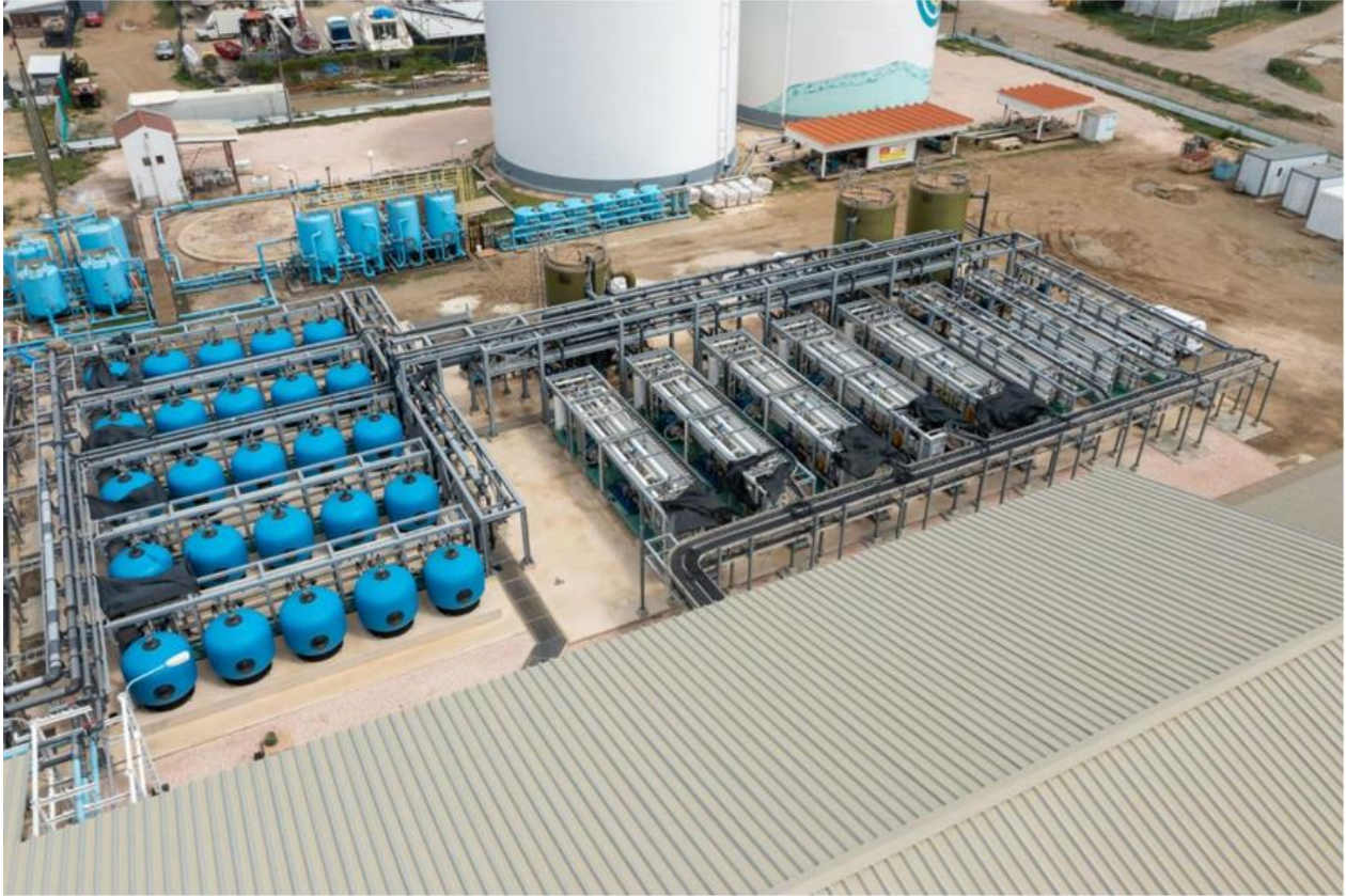
Afbeelding 10: Snelfilters bij de drinkwaterzuivering Hato op Bonaire. Alle blauwe vaten zijn snelfilters, waarbij de vaten links op de voorgrond een diameter van 2,5 meter hebben.
