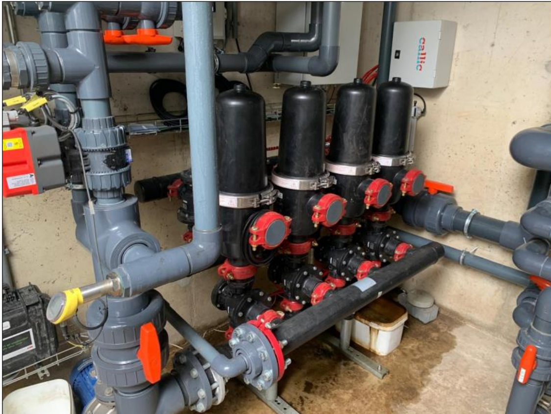
Afbeelding 5: voorfilter bij Zwemlust
