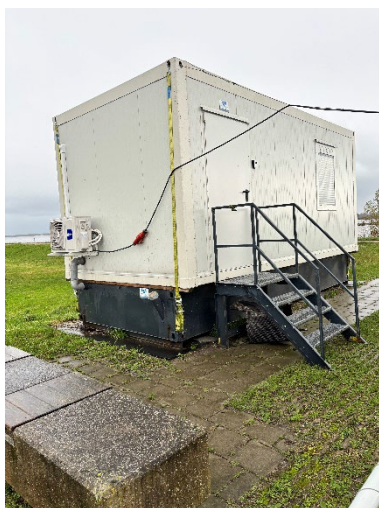
Figuur 2: Foto sluiswachtershuisje met op de voorgrond nog een deel van het kunstwerk
