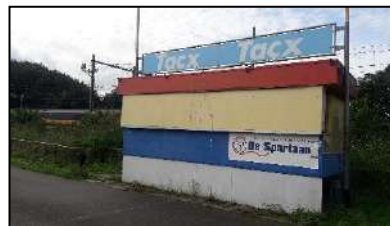
Figuur 16. Bijgebouw wielrenparcours zuidwestzijde onderzoekslocatie.
