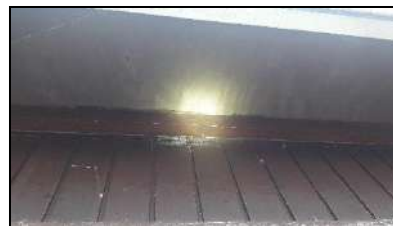
Figuur 13. Detail clubgebouw 'De Spartaan'.
