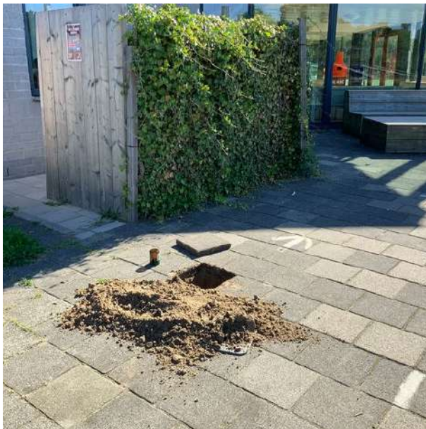
Foto 3: Locatie B ter hoogte van de kantine
