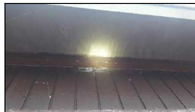
Figuur 13. Detail clubgebouw 'De Spartaan'.
