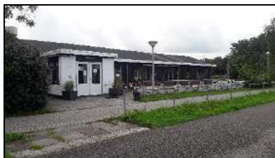
Figuur 12. Voorzijde clubgebouw 'De Spartaan'.
