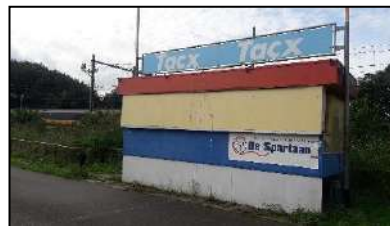
Figuur 16. Bijgebouw wielrenparcours zuidwestzijde onderzoekslocatie.
