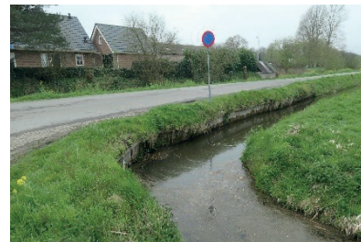
Houten damwand Goyerweg
