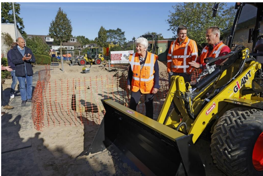
Start werkzaamheden Bijvanck
