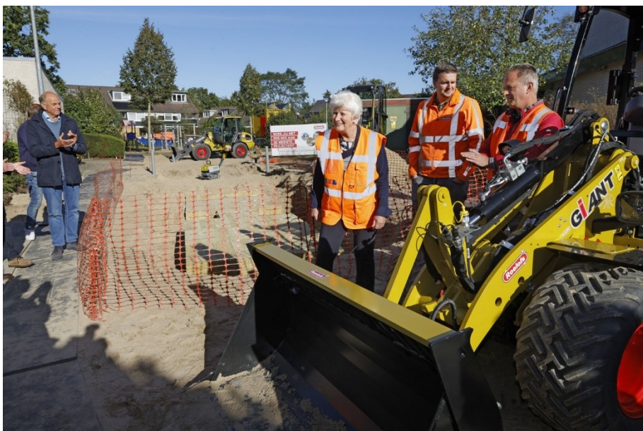
Start werkzaamheden Bijvanck
