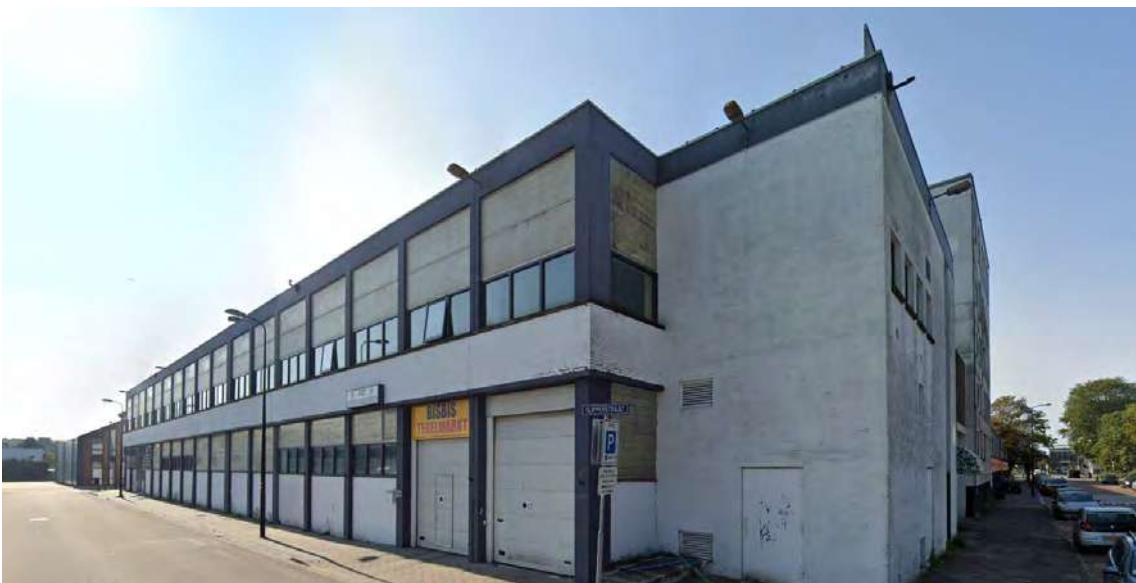
Foto 2.3: Indolafabriek gezien vanaf de Klipperstraat (bron: Google streetview)
