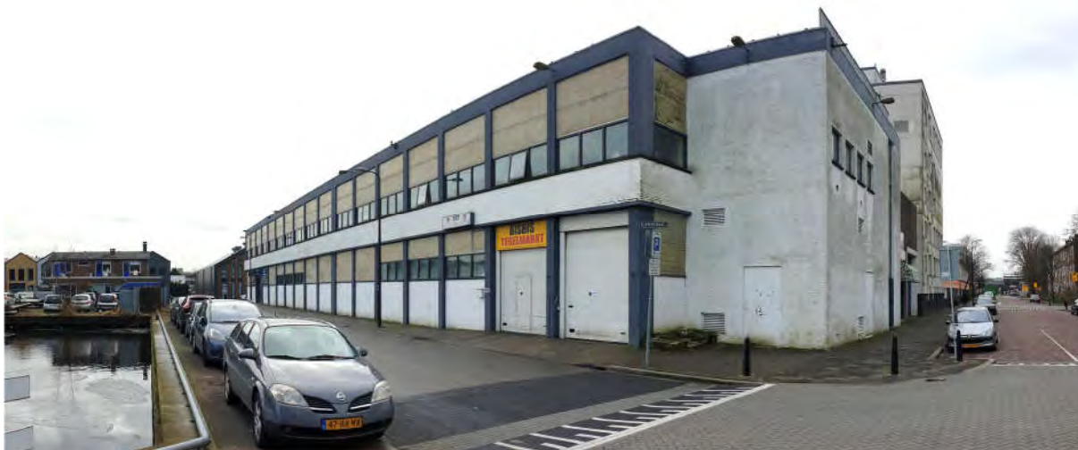
Foto 2: Noordoostelijke en noordwestelijke gevels van het gebouw, met links het water van de haven. Zicht in zuidelijke richting.
