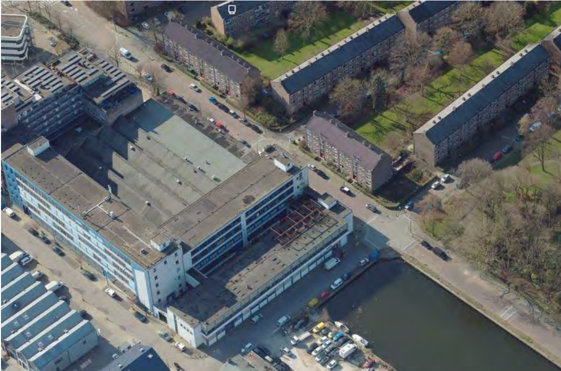
Figuur 2.2: Luchtfoto van het plangebied gezien vanaf de insteekhaven
