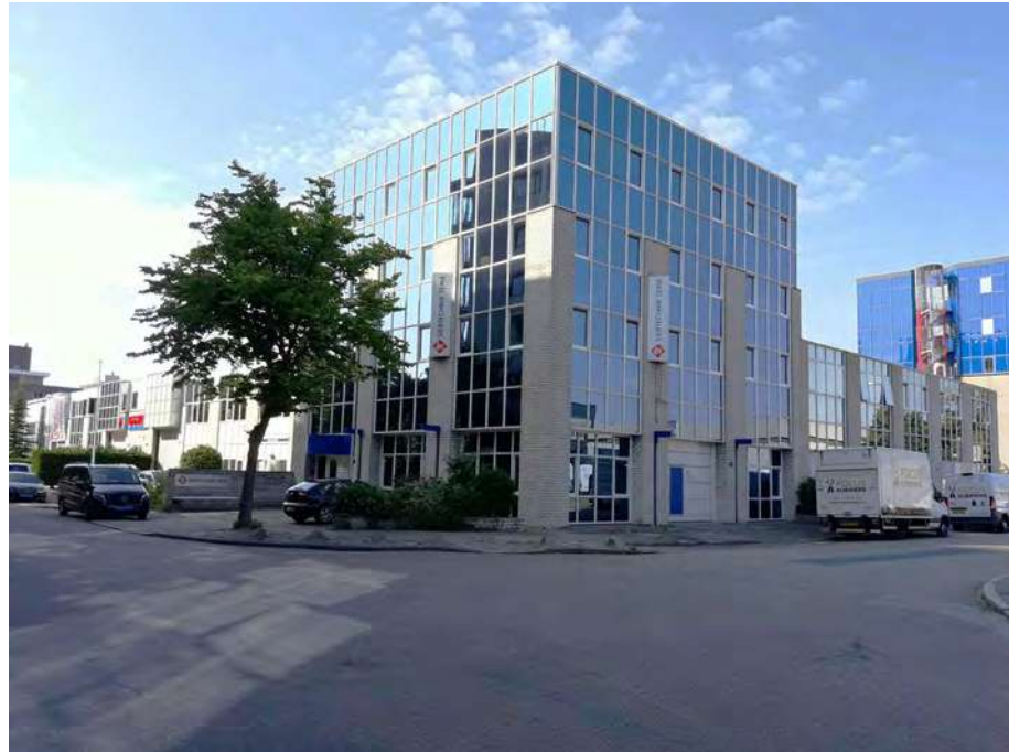
Afbeelding 7. Bedrijfspanden op de hoek Steenplaatsstraat - Koopmansstraat. Foto: BMA
