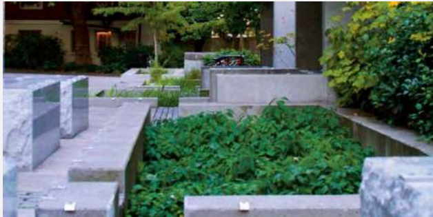
Infiltratiestroken met bovengrondse opslag
