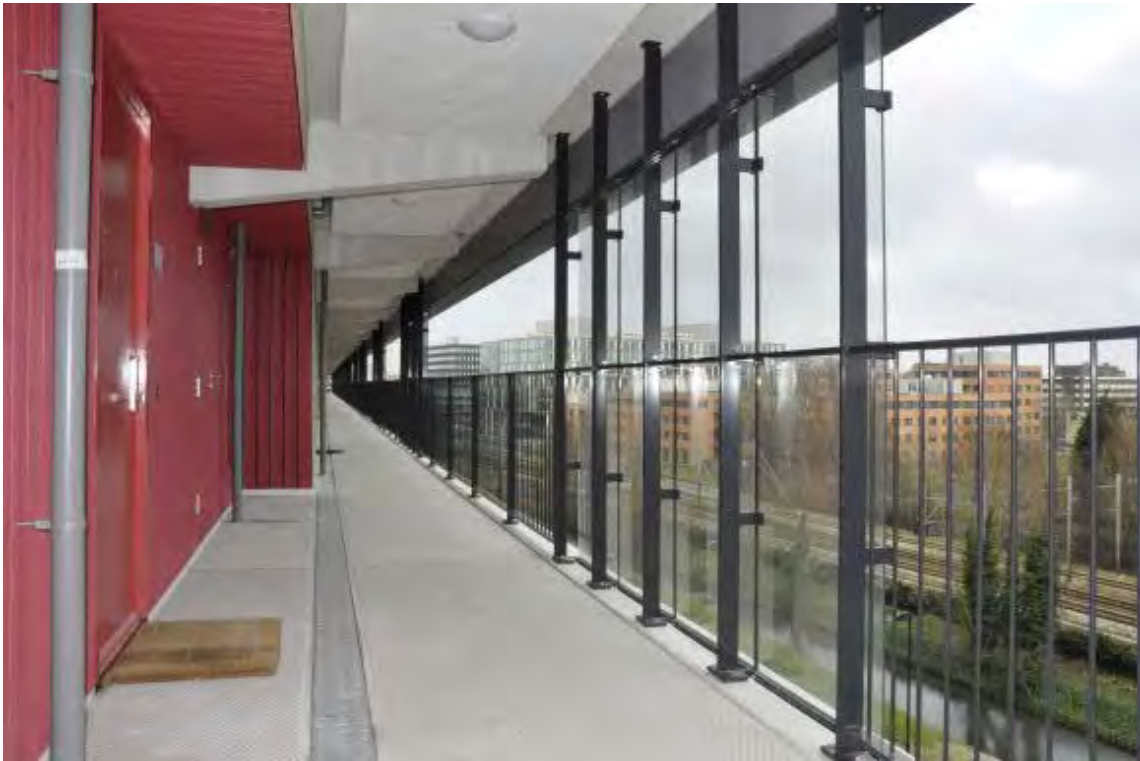
Afbeelding 2: Pauline Symfonie, gedeeltelijk afscherming gekoppeld aan de borstwering van de balustrade. Met de afscherming wordt een te hoge geluidsbelasting voorkomen op het gedeelte van de gevel waar zich een te openen gedeelte bevindt. In dit geval de voordeur van de woning. .
