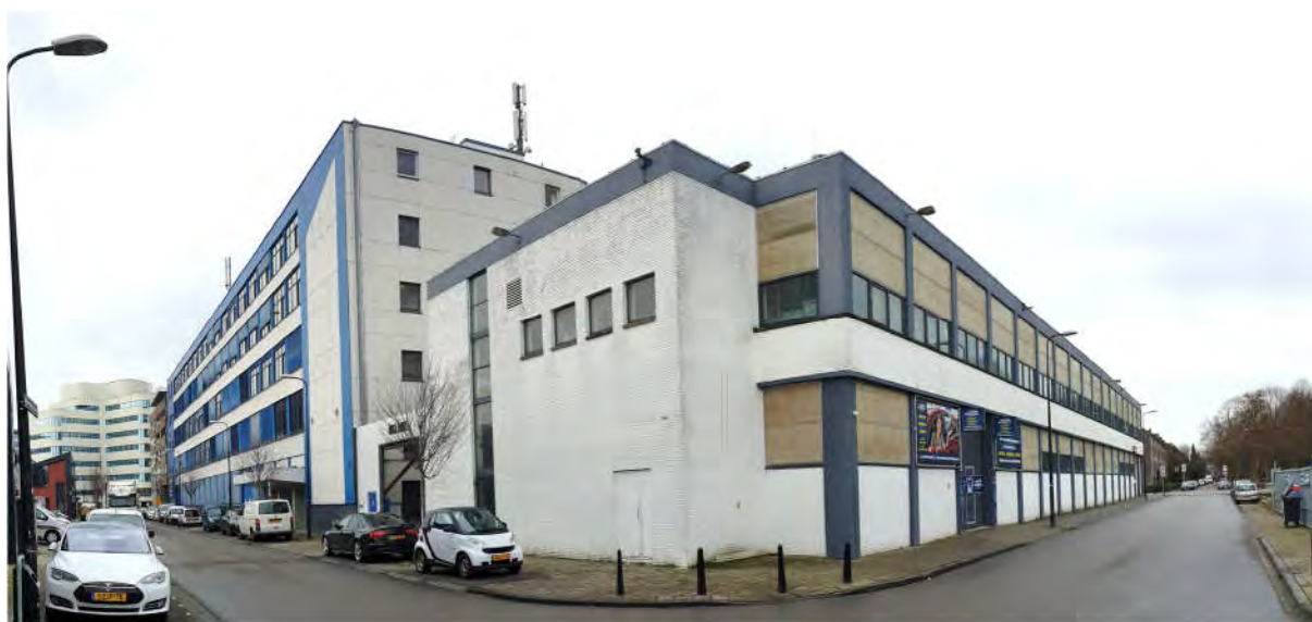
Foto 1: Noordoostelijke en zuidoostelijke gevels van bebouwing. Zicht in westelijke richting.
