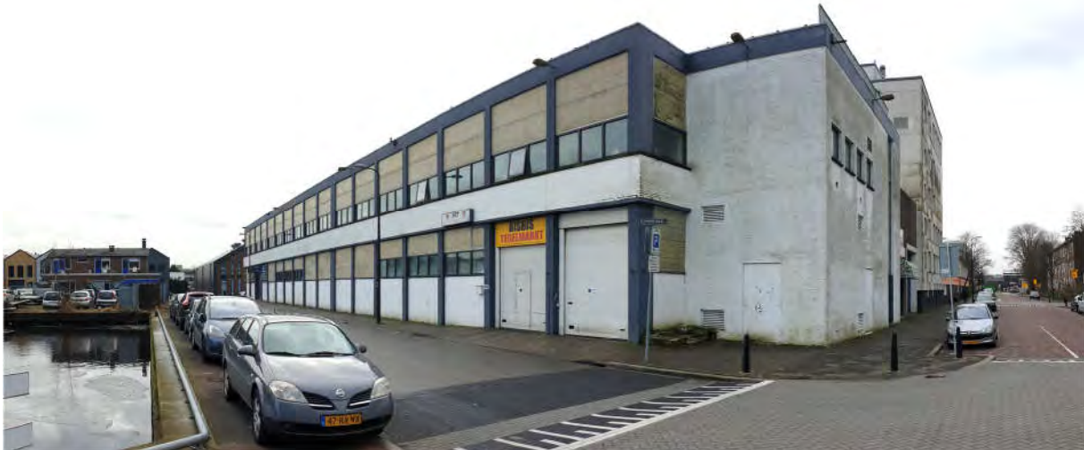
Foto 2: Noordoostelijke en noordwestelijke gevels van het gebouw, met links het water van de haven. Zicht in zuidelijke richting.
