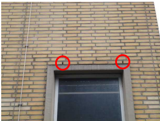
Links open stootvoegen boven een raam. Rechts de constructie van natuursteen waar vleermuizen mogelijk in kunnen verblijven.
