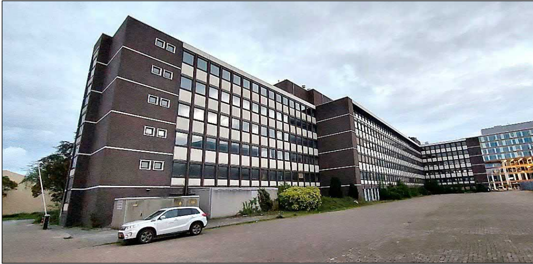
Figuur 3. Impressie van het plangebied aan de noordzijde. Kopse kanten en tussenstukken met open stootvoegen.
