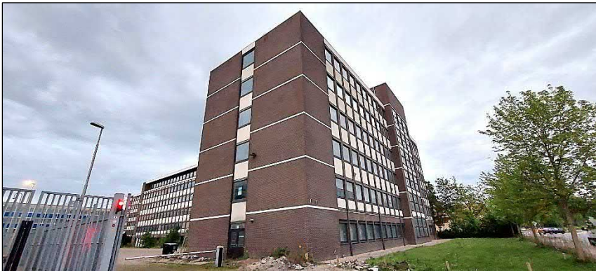
Figuur 4. Kantoorpand noordzijde kopse kant. Grasveld aan de Lange Kleiweg.
