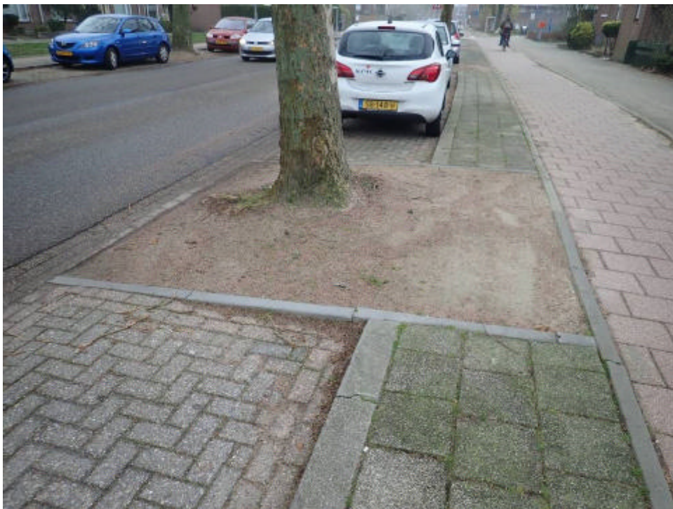
Foto 12: Voorbeeld van een vergrootte boomspiegel waarbij de tegelverharding van het trottoir is omgevormd tot halfverharding.
