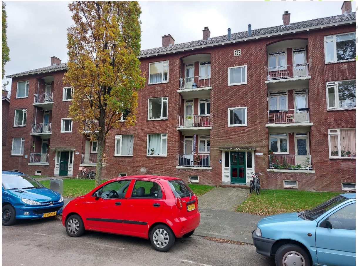
Figuur 5. Appartementencomplex gelegen aan de Karel Doormanlaan. Foto: G.S. Posthuma | Ecoresult B.V.
