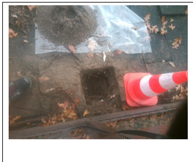
Foto 18. Asbestinspectiegat 21
