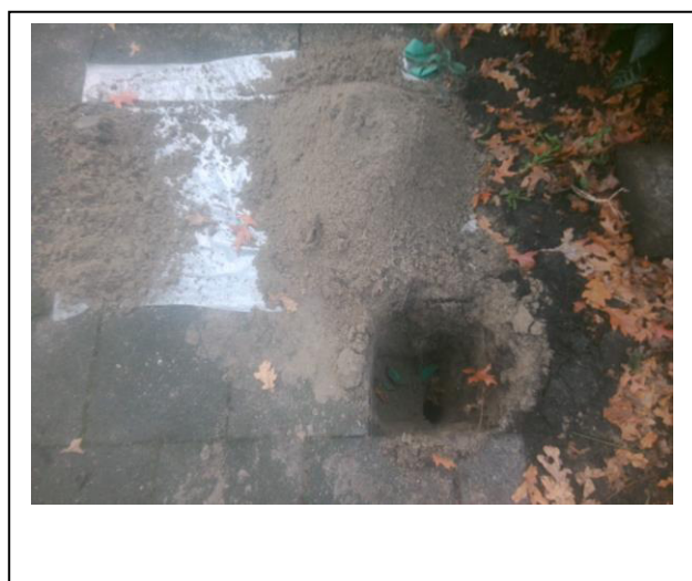
Foto 30. Asbestinspectiegat 35
