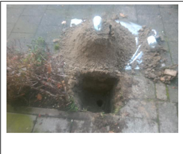
Foto 21. Asbestinspectiegat 24
