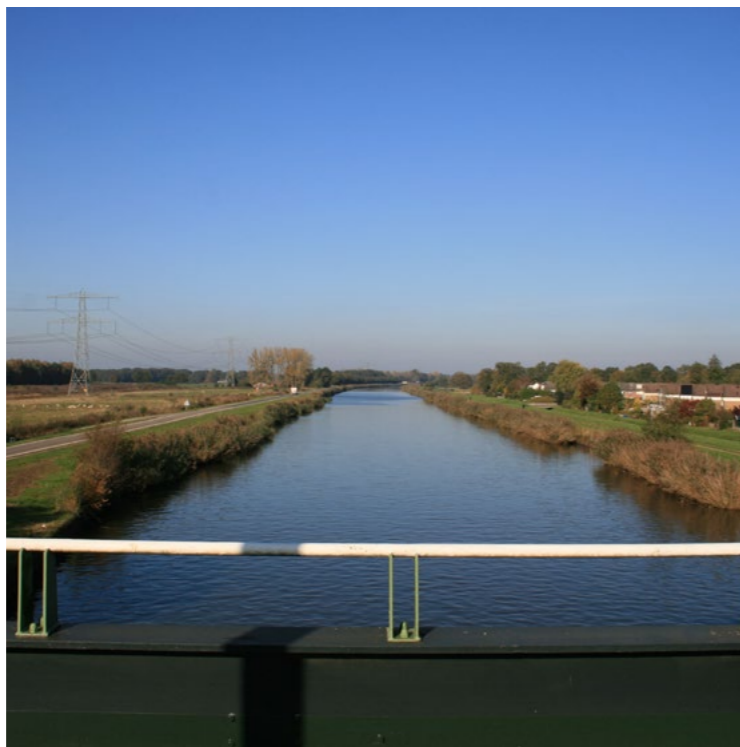
Zicht op het Twentekanaal vanaf de brug in noordelijke richting.
