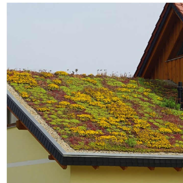
Een groen dak zorgt voor betere isolatie, biodiversiteit en waterberging.
