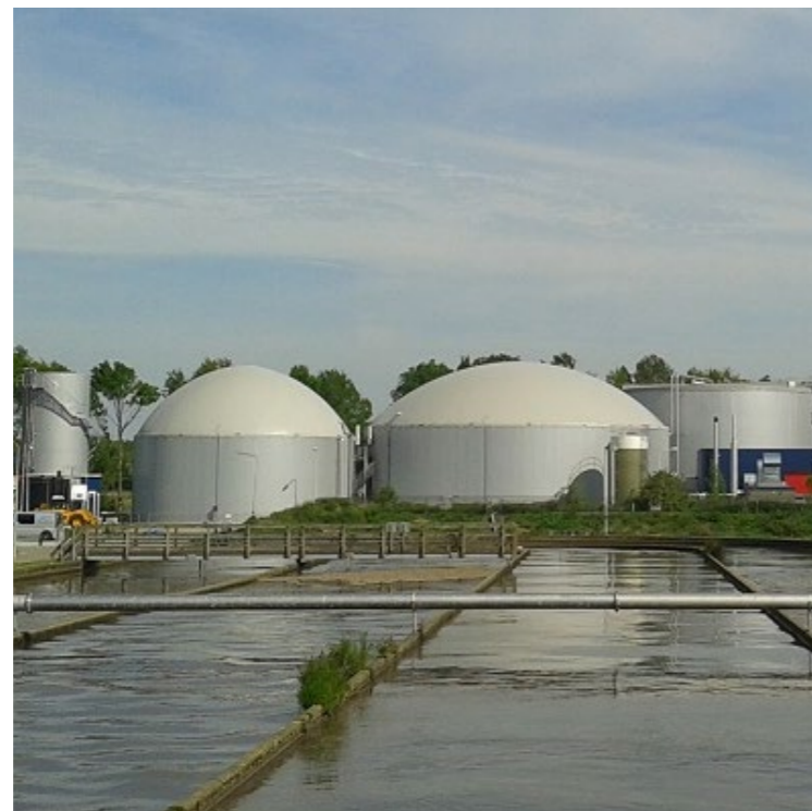
Biogasinstallatie gekoppeld aan RWZI.
