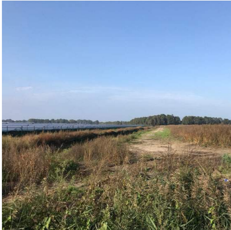
Oostelijke rand van zonnepark Aadijk vormt de recreatieve verbinding tussen de noordelijke groene long en landelijk gebied.
