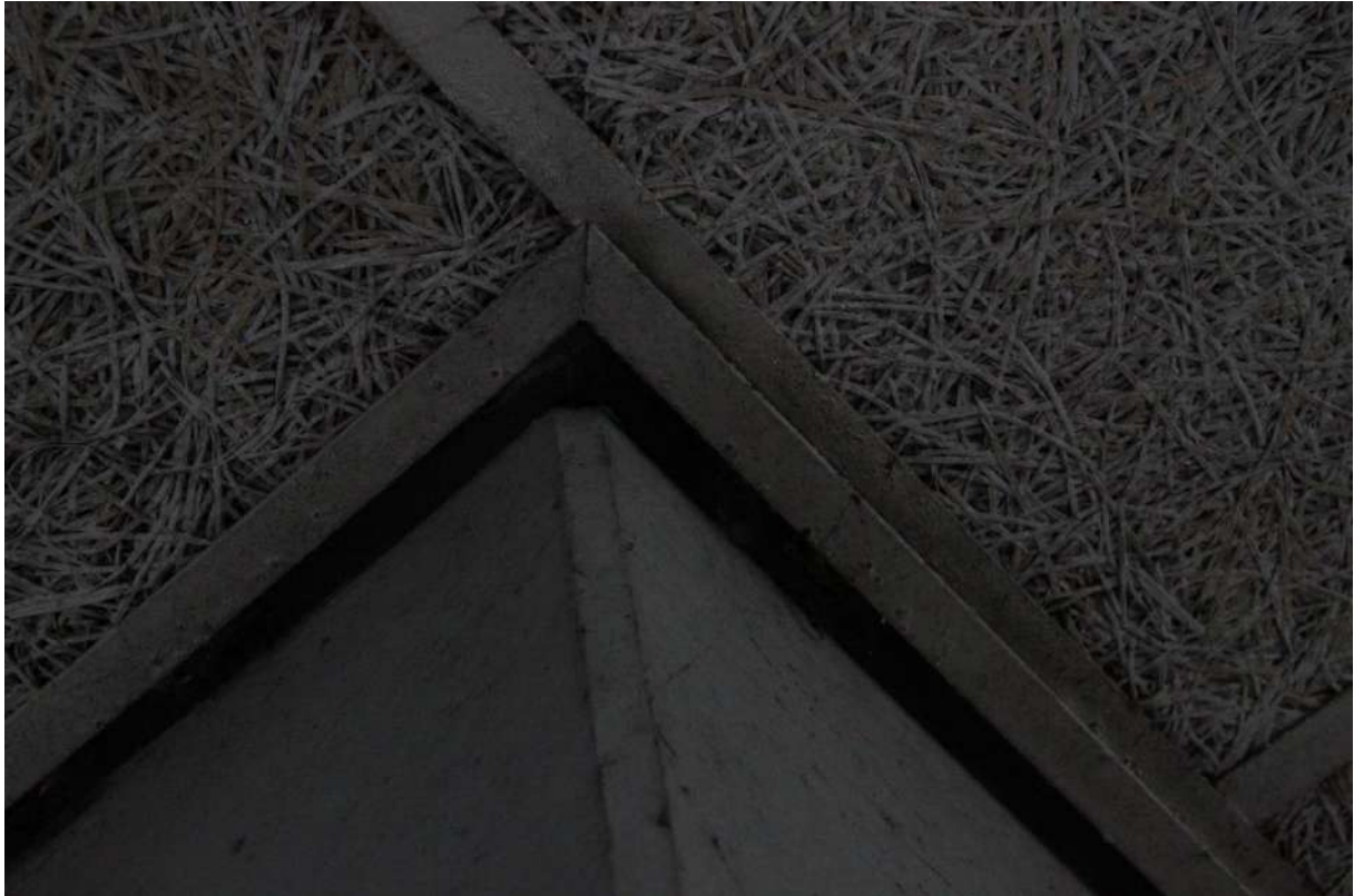
Figuur 14: De ruimte tussen het beton en plafond is dicht met rubber.
