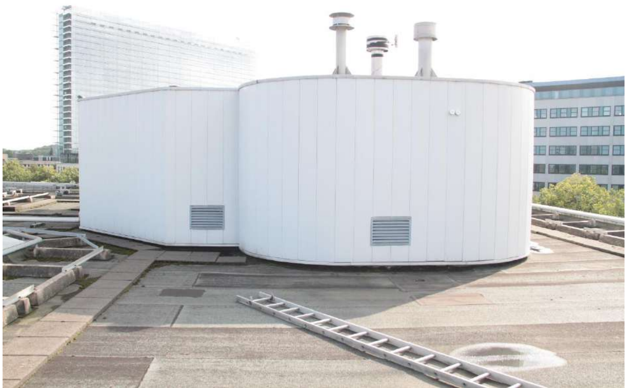
Figuur 5: Het dak van het kantoorgebouw gezien vanaf de andere zijde.
