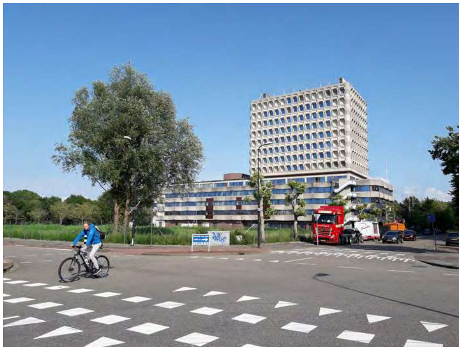
Afbeelding 8. Het gebouw van voorheen de Sijthoff Pers op de hoek Limpergstraat - Van Benthemlaan. Foto: BMA
