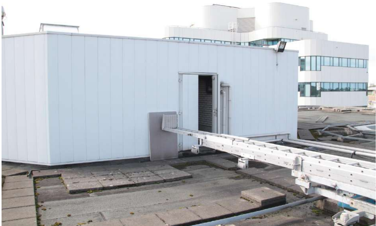
Figuur 6: Het dak van het kantoorgebouw.
