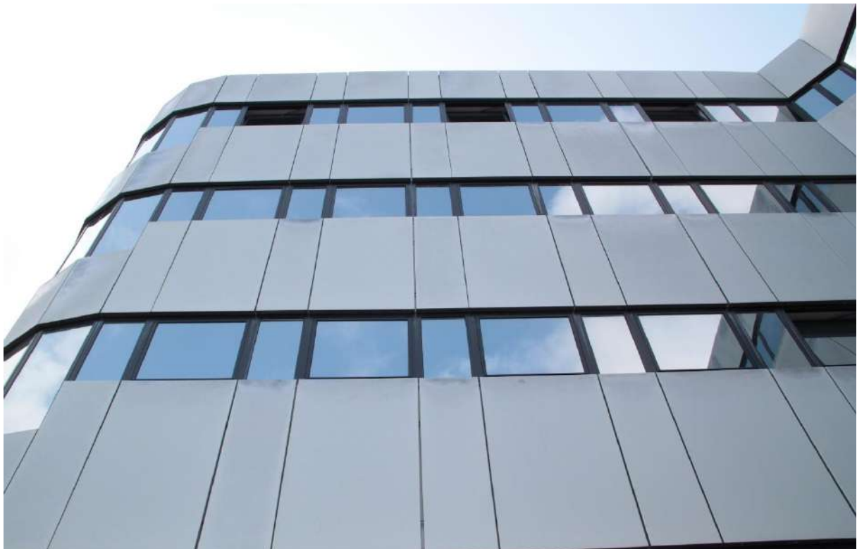
Figuur 4: De gevel bestaat uit metalen panelen, kunststof en glas, afgewerkt met rubber. Gladde oppervlaktes zijn ongeschikt voor vleermuizen.
