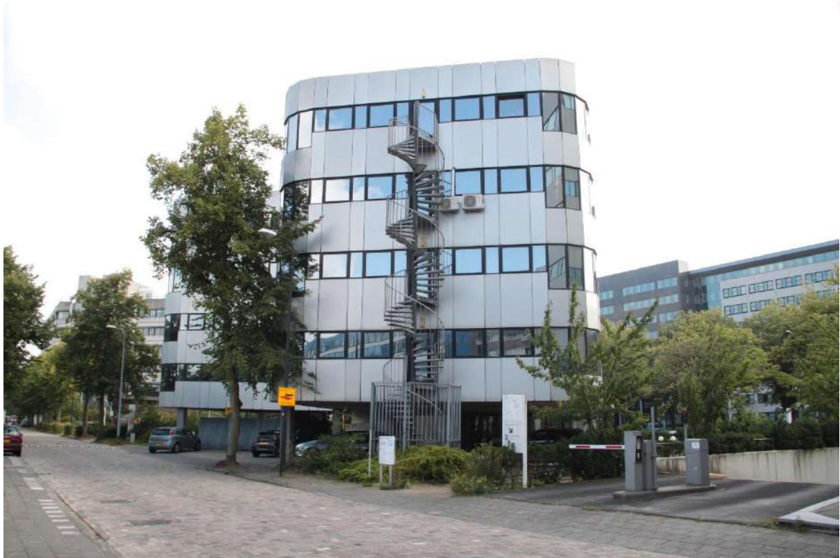
Figuur 3: Vooraanzicht kantoorgebouw.
