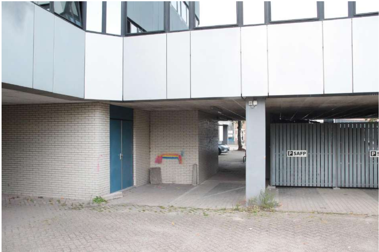
Figuur 9: Onder het centrale gedeelte van het gebouw bevindt zich de ingang naar het trappenhuis en een stalling.
