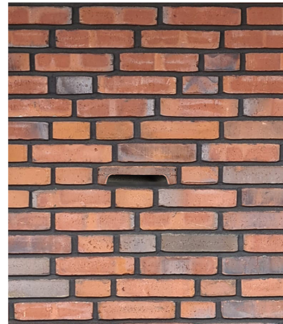
Vleermuis nestkast iets verdiept verwerkt in het metselwerk en afgewerkt met steenstrips (gezaagd uit de toegepaste gevelsteen). Optie 2 in tekening hierboven.
