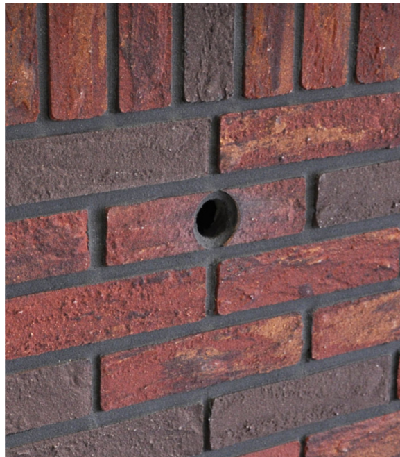
Huismus nestkast iets verdiept verwerkt in het metselwerk en afgewerkt met steenstrips (gezaagd uit de toegepaste gevelsteen). Dit zelfde verwerkingsprincipe geldt ook voor de nestkast van de gierwaluw.
