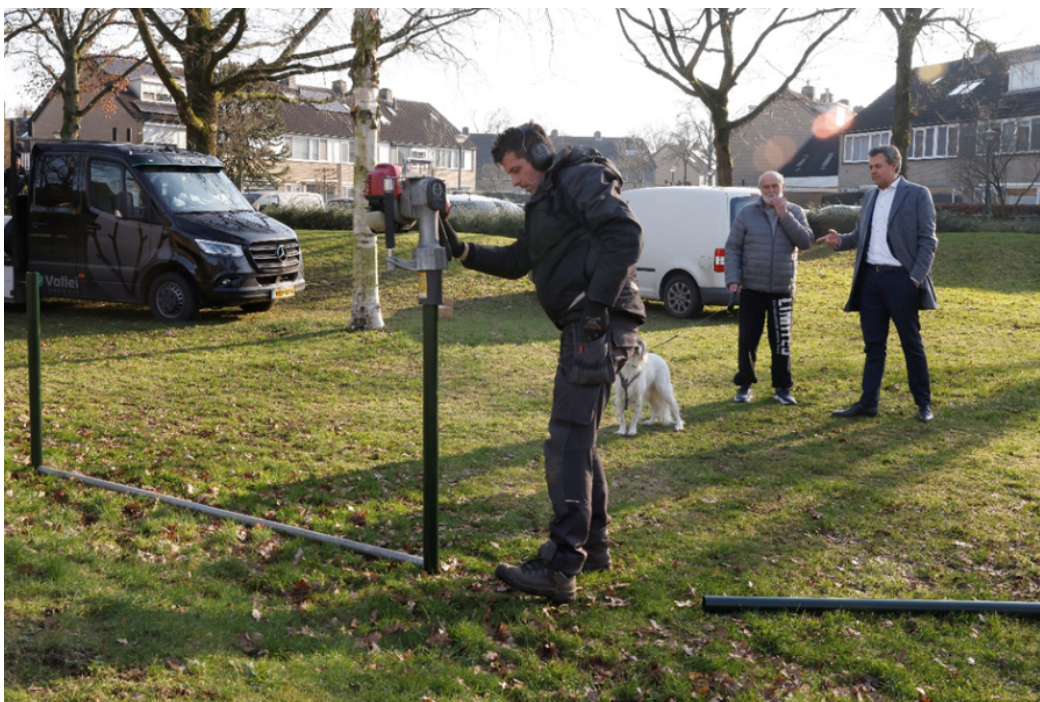
Foto: aanleg hekwerk hondenspeelveld Fazantenhof
