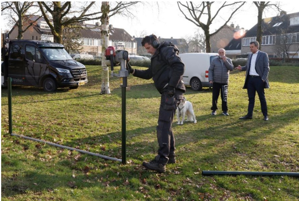
Foto: aanleg hekwerk hondenspeelveld Fazantenhof
