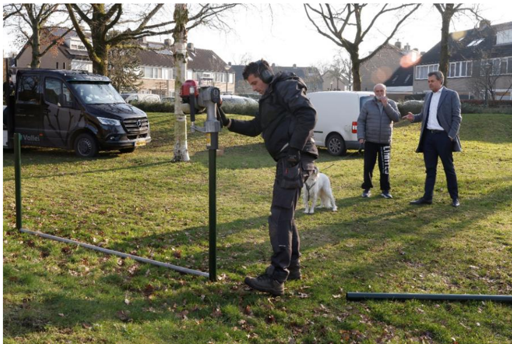
Foto: aanleg hekwerk hondenspeelveld Fazantenhof
