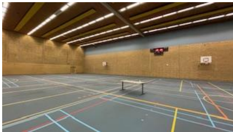
Foto 4: Interieur hal; rechts is achtergevel
