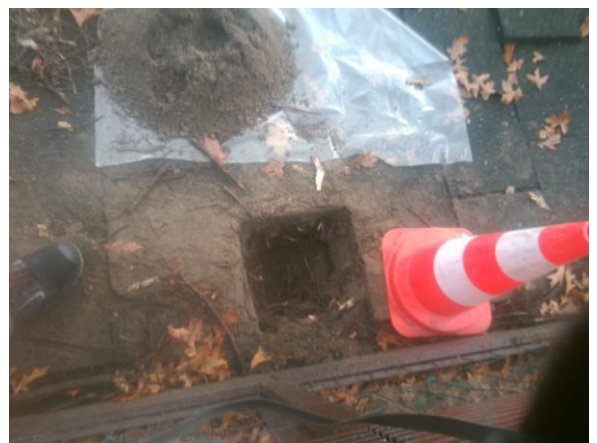
Foto 18. Asbestinspectiegat 21
