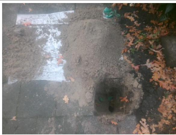
Foto 30. Asbestinspectiegat 35
