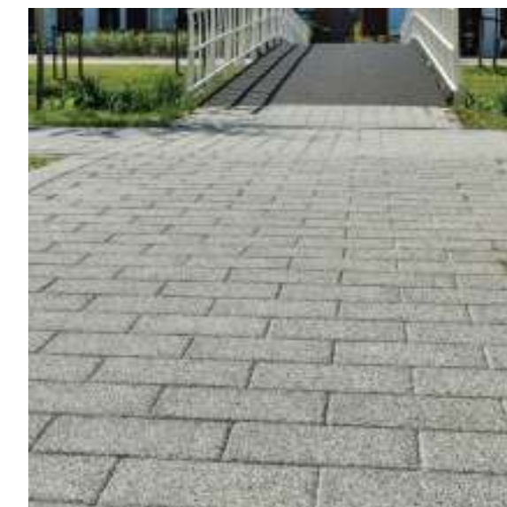
Trottoir in betontegels met basaltafstrooilaag
