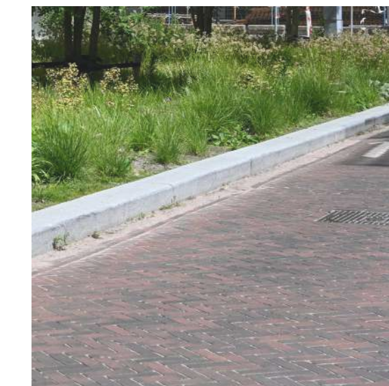
Rijbaan in gebakken klinkers
