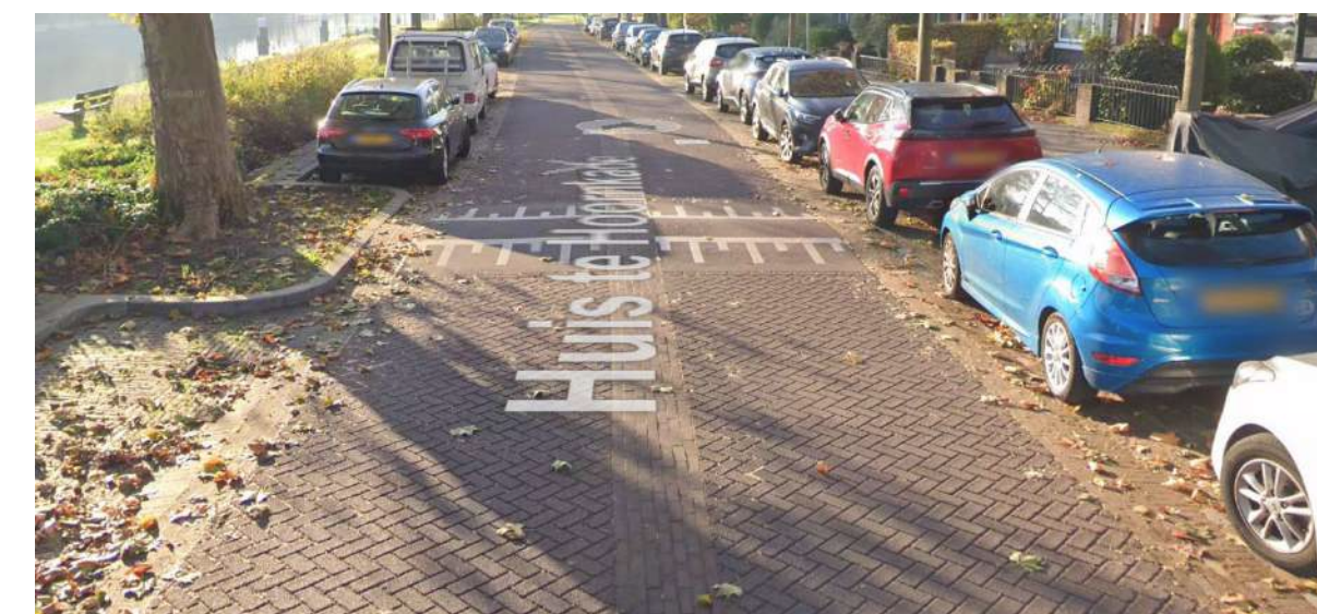
30km/uur straat in paars asfalt met klinkerprint
