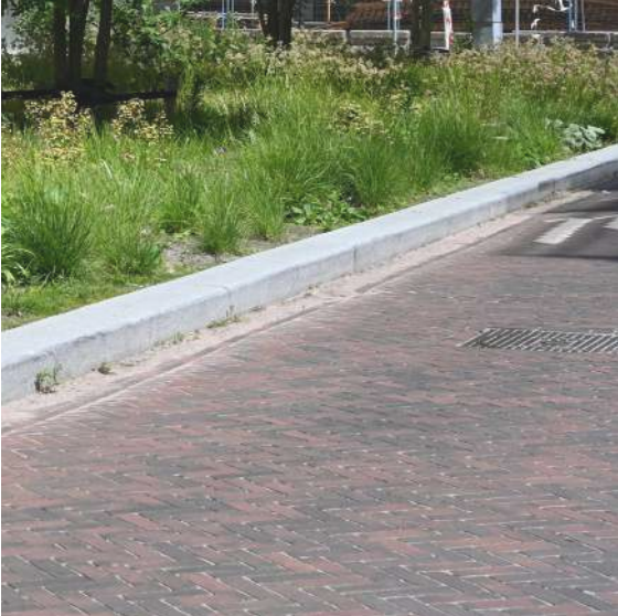
Rijbaan in gebakken klinkers
