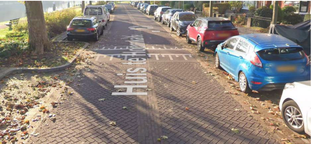
30km/uur straat in paars asfalt met klinkerprint
