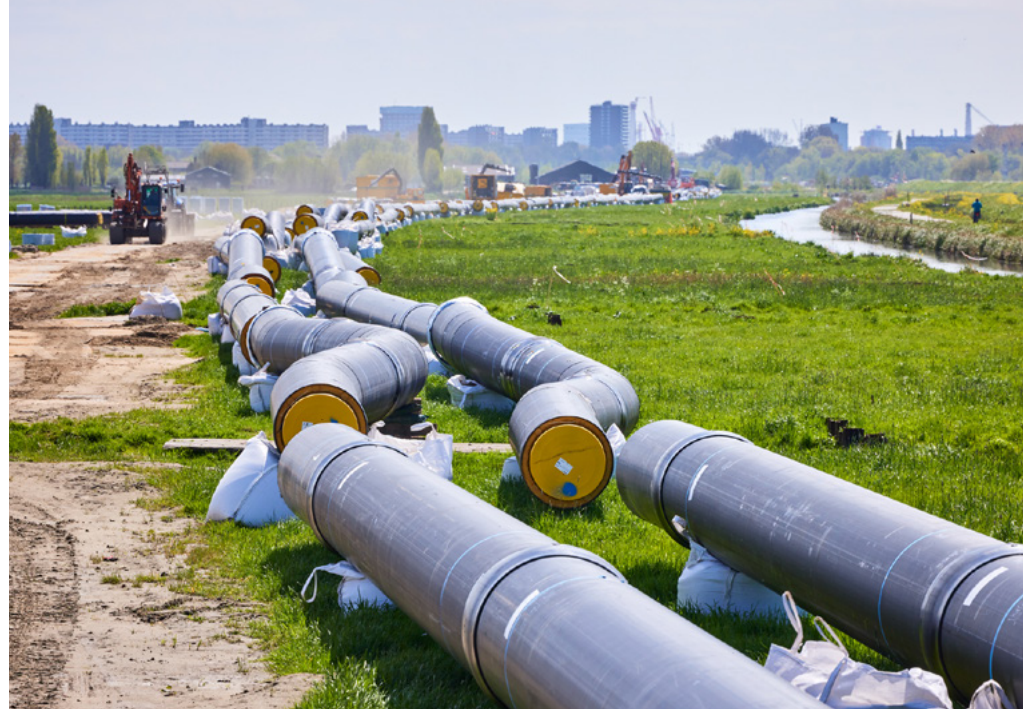
Foto: warmteleidingen tussen Delft en Vlaardingen (fotograaf: Vincent Basler, Warmteling)
