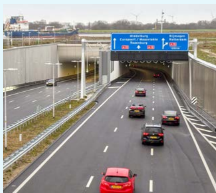
Maasdeltatunnel, gezien vanaf het noorden. Foto: Rijkswaterstaat
