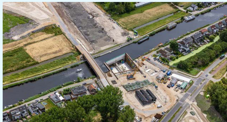
Aanleg tunnel onder de Rotte. Foto: Rijkswaterstaat
