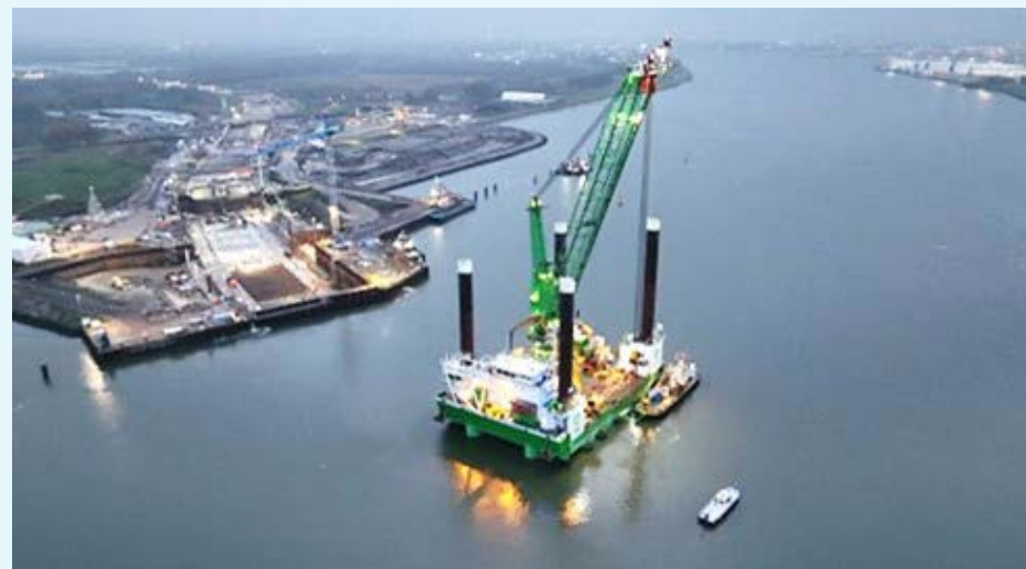
Aanleg tunnel in de Blankenburgverbinding. Foto: Rijkswaterstaat
