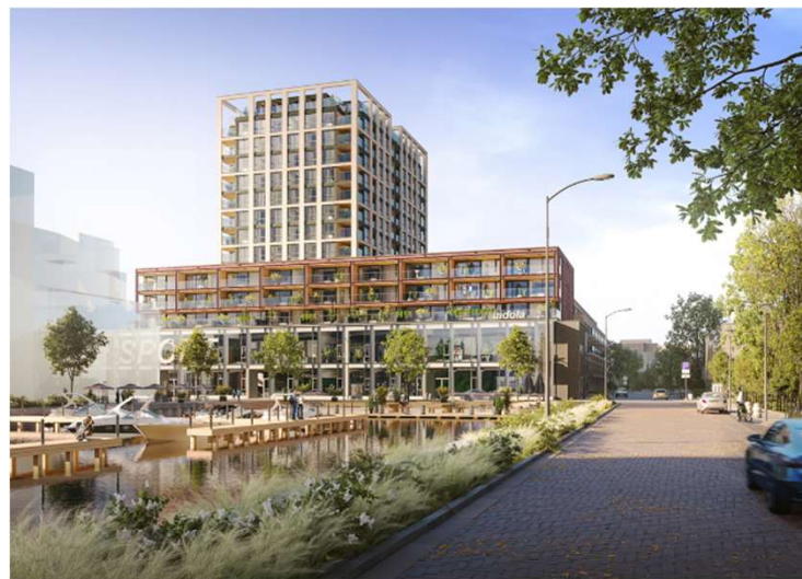
Harbourpark: (voorzieningen, bedrijven en wonen) juli 2025 omgevingsvergunning verleend sloop/start bouw begin 2026
