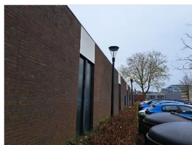
Figuur 2.12 Zuidzijde van gebouw 2.
