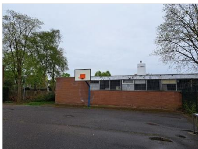
Figuur 2.10 Noordzijde van gebouw 1.
