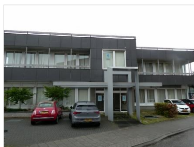
Figuur 2.13 Oostzijde van gebouw 3.
