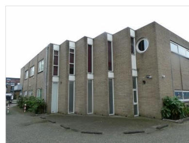
Figuur 2.20 Noordzijde van gebouw 6.
