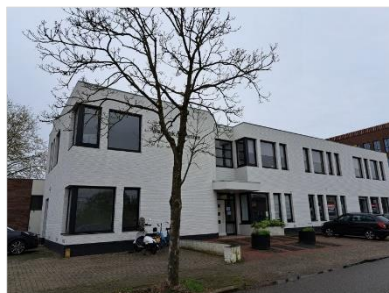
Figuur 2.11 Noordzijde van gebouw 2.
