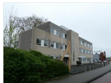
Figuur 2.17 Oostzijde van gebouw 5.
