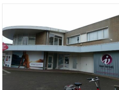
Figuur 2.19 Zuidzijde van gebouw 6.
