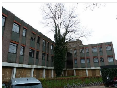
Figuur 2.16 Oostzijde van gebouw 4.
