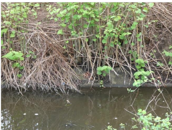
Figuur 4.5 Oevers gedeeltelijk bestaande uit beton.
