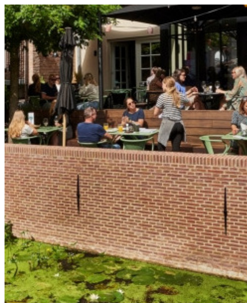
Parkkade klinkermix met deels hergebruik bestaande klinker Haven Noordzijde, kleur: mix van beige, bruin en bruinrood
