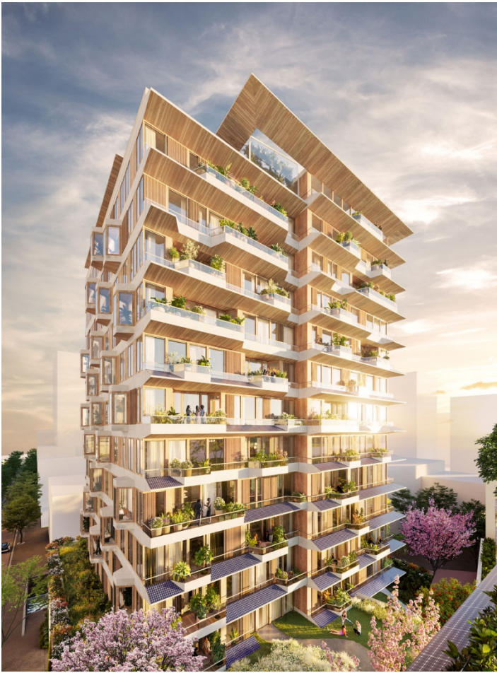
Figuur 14 – PV op gevel, onder helling geplaatst en verticaal
