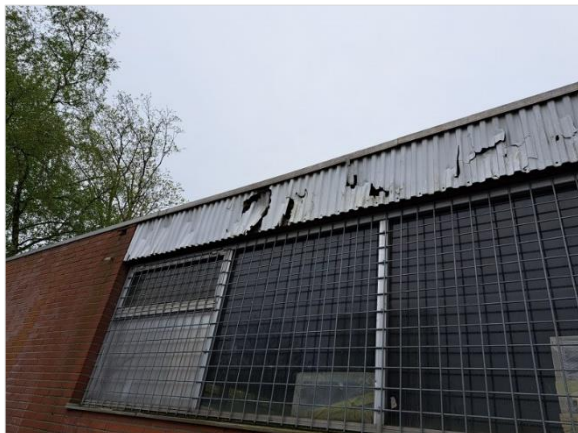
Figuur 4.1 Geschikte openingen in de noordgevel van gebouw 1.
