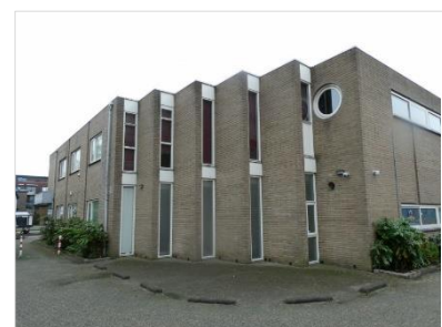
Figuur 2.20 Noordzijde van gebouw 6.
