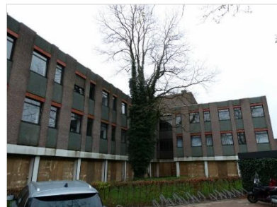
Figuur 2.16 Oostzijde van gebouw 4.
