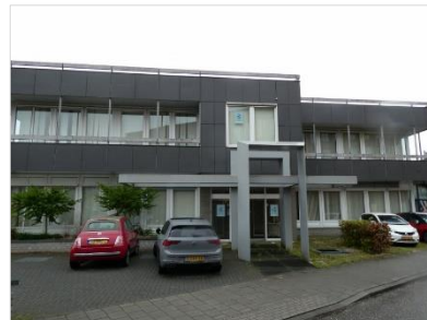
Figuur 2.13 Oostzijde van gebouw 3.
