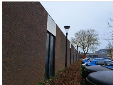
Figuur 2.12 Zuidzijde van gebouw 2.
