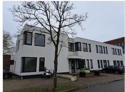
Figuur 2.11 Noordzijde van gebouw 2.
