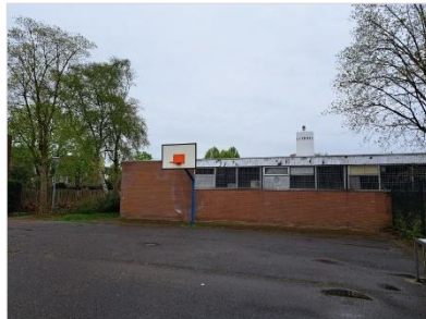
Figuur 2.10 Noordzijde van gebouw 1.
