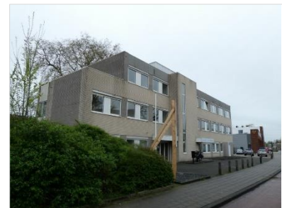
Figuur 2.17 Oostzijde van gebouw 5.
