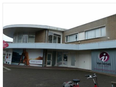
Figuur 2.19 Zuidzijde van gebouw 6.
