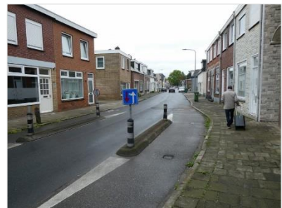
Figuur 2.5 Impressie van de onderzoekslocatie, gelegen aan de zuidzijde.
