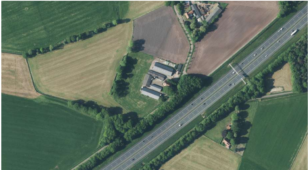
Afbeelding 2.6: Luchtfoto van slooplocatie Bolscher Landen (bron: Topotijdreis)
