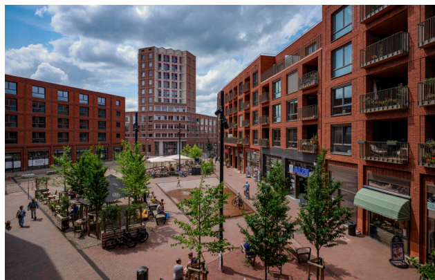
Een gelimiteerd materialenpalet bestaand uit warme bruin- en roodtinten vormt de basis van de Stadskade - Hart van de Waalsprong, Nijmegen (ontwerp: De Zwarte Hond).
