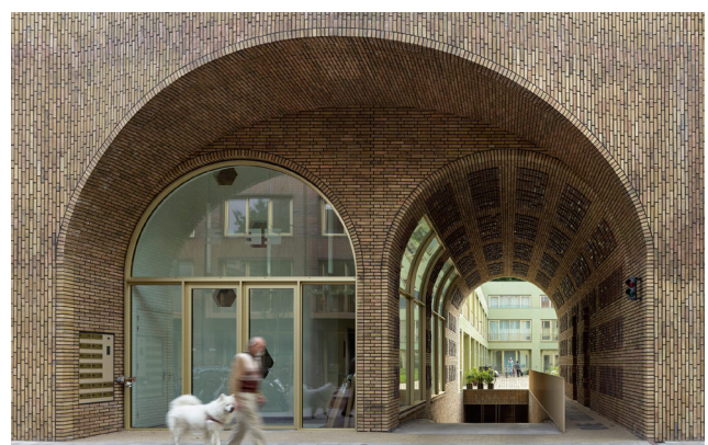
Binnentuinen zijn toegankelijk door poorten die onderdeel zijn van het hoofdvolume - Spaandammerhart, Amsterdam (ontwerp: Marcel Lok_Architect & Korth Tielens Architects).
