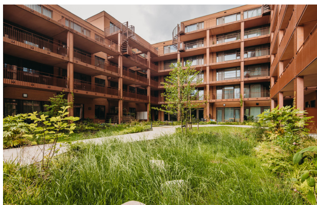
Bij verbetering van gevels aan de binnentuin zorgt afstemming van kleur van de gevel met toevoegingen zoals balkons en trappen voor een rustig beeld - Grunobuurt, Groningen (ontwerp: De Zwarte Hond).
