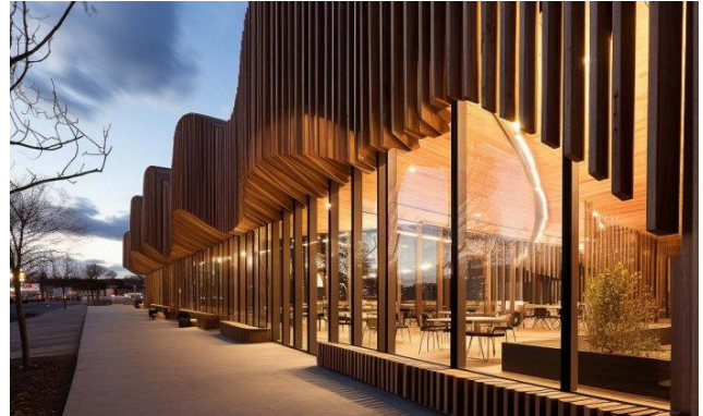
De gevel heeft waar het achtergelegen programma het mogelijk maakt een transparant karakter - Parkeershuis Nijmegen (ontwerp: Korthtielens architecten).
