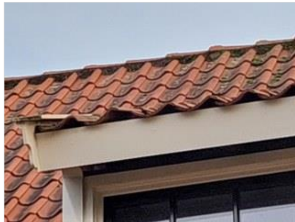
Figuur 4.10 Ruimte onder de dakpannen geeft ruimte voor vleermuizen.
