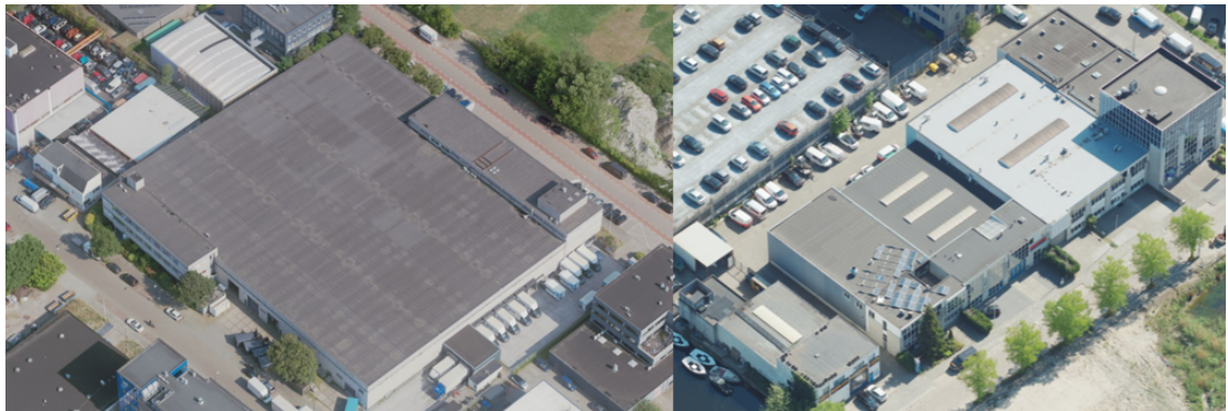
Figuur 7 Luchtfoto's bestaande situatie, bedrijf aan de Limpergstraat links, bedrijven aan de Koopmansstraat 5-5f rechts (bron: Street Smart by Cyclomedia, 2025)
