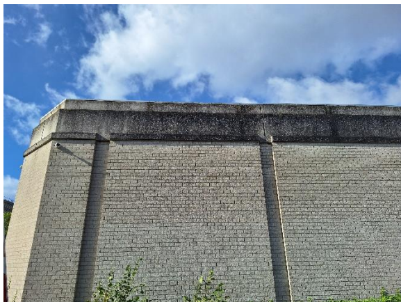
F. Pand 5: Limpergstraat 2. Open stootvoegen aanwezig in rond de gehele gevel.
