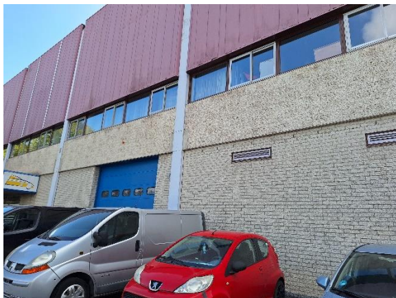
F. Pand 5: Limpergstraat 2. Open stootvoegen aanwezig in rond de gehele gevel.
