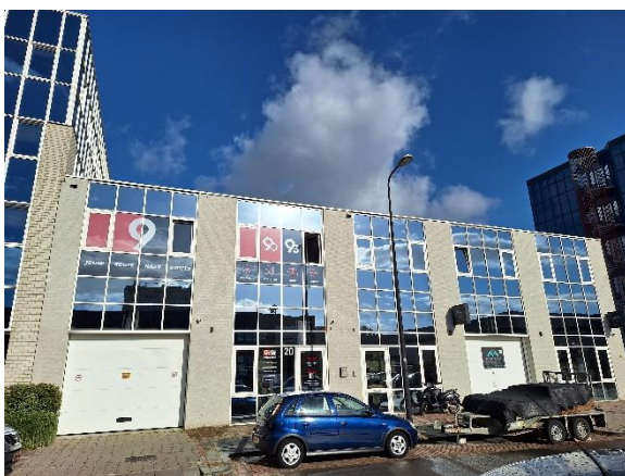
B. Pand 1: Steenplaatsstraat 18 en 20. Open stootvoegen aanwezig net onder de daklijst.
